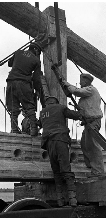
Baustelle des Bunkers ›Valentin‹ im Sommer 1944 Foto: Johann Seubert, © Landeszentrale für politische Bildung Bremen
