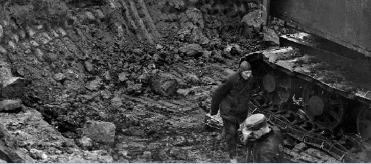
Baustelle des Bunkers ›Valentin‹ im Sommer 1944
